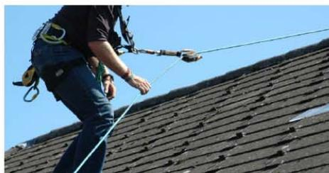
1 Bereits bei der Massaufnahme besteht Absturz- oder Durchbruchgefahr. Eine fachgerechte Sicherung ist unumgänglich.
